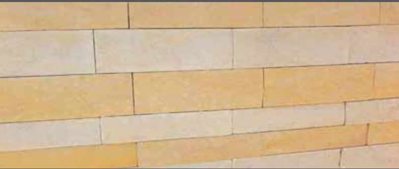
Warthauer Sandstein, Schichtmauerwerk gespalten
