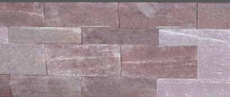
Olsbrücker Sandstein, Schichtmauerwerk gespalten
