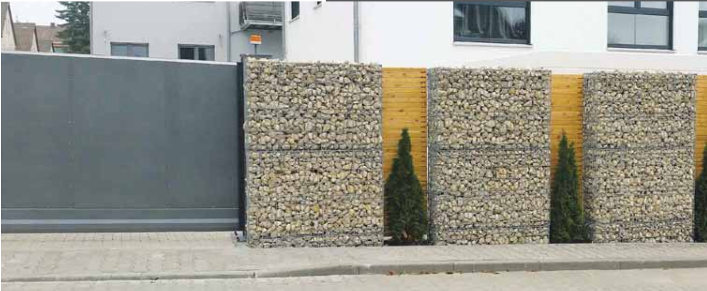
Sichtschutzwand, Pfraundorfer Dolomit 63/125, geschüttet
