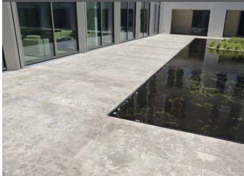
Pfraundorfer Dolomit, Bodenplatten
