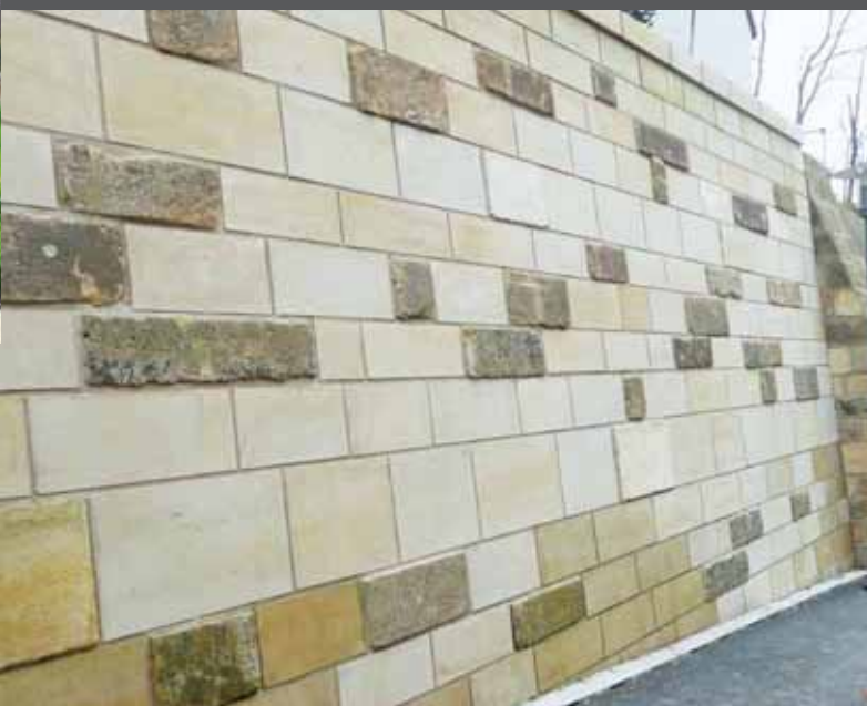
Warthauer Sandstein, Mauersteine gesägt
