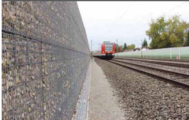
Sileno Plus, Lärmschutzwand, Pfraundorfer Dolomit, geschüttet
