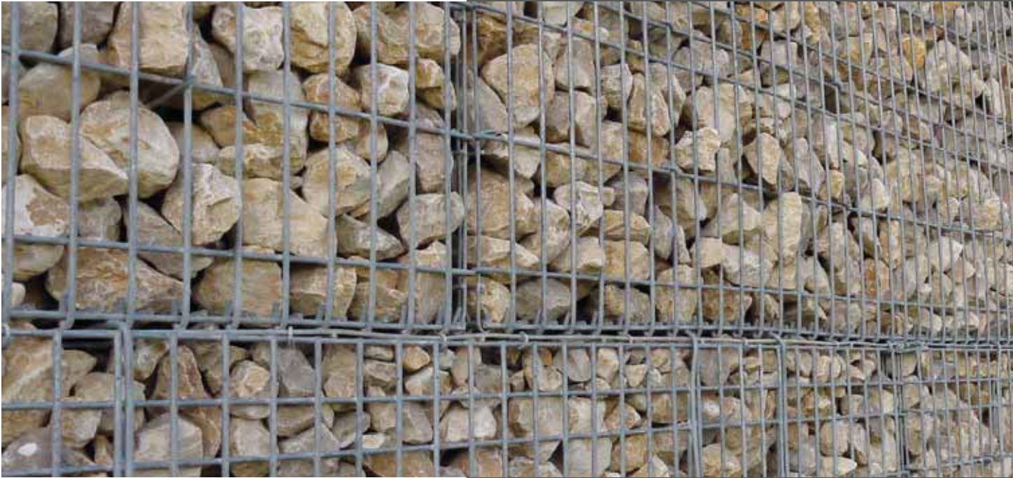
Sileno Plus, Lärmschutzwand, Pfraundorfer Dolomit, geschüttet
