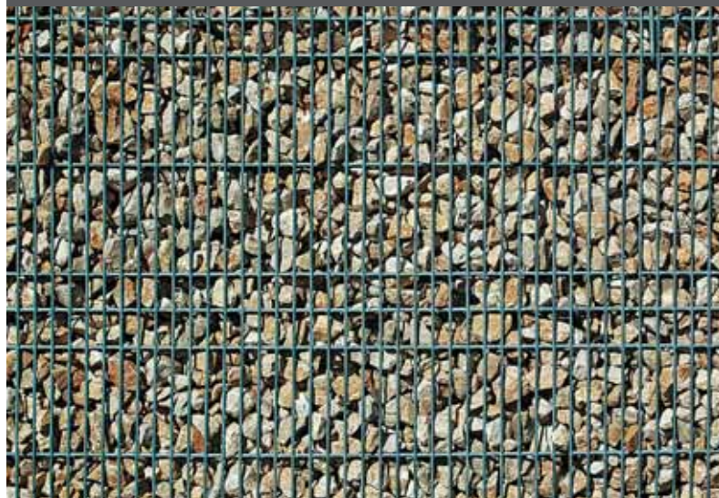
Sileno Plus, Lärmschutzwand, Pfraundorfer Dolomit, geschüttet
